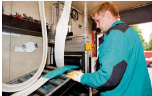
Vorbereitung Inlinerschlauch mit 2-Komponenten-Harz
